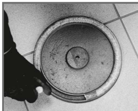
Fot. Wymiana sznura uszczelniającego.
