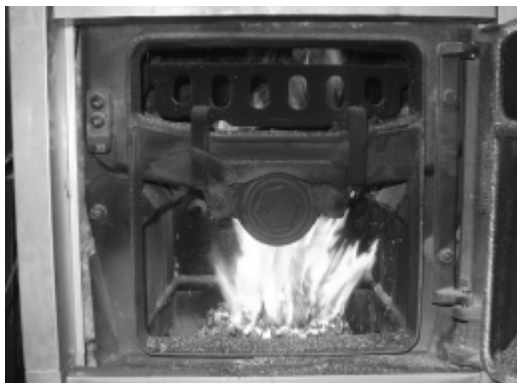
Rys. nr. 37 Kształt optymalny płomieni
