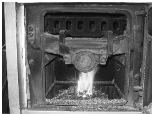
Rys. nr. 38 Nieodpowiedni kształt płomieni
