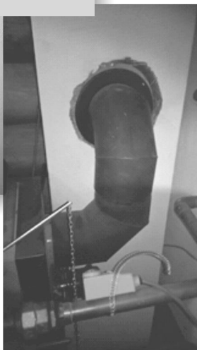
niewłaściwe podłączenie do czopucha – nieszczelne i brak możliwości czyszczenia
