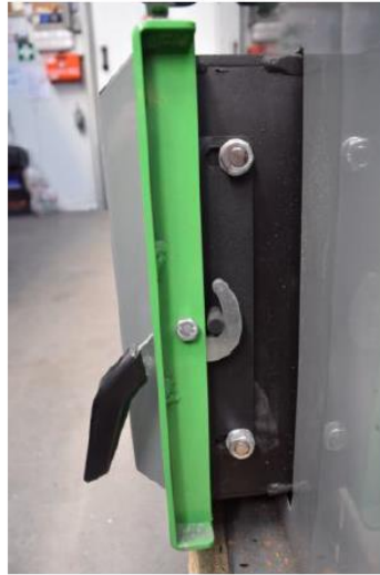
Fot.13. Aschkasten-Tür (Verschlussart - krank geschlossen)
