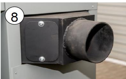
Fot. 8. Rauchfang des Schornsteins
