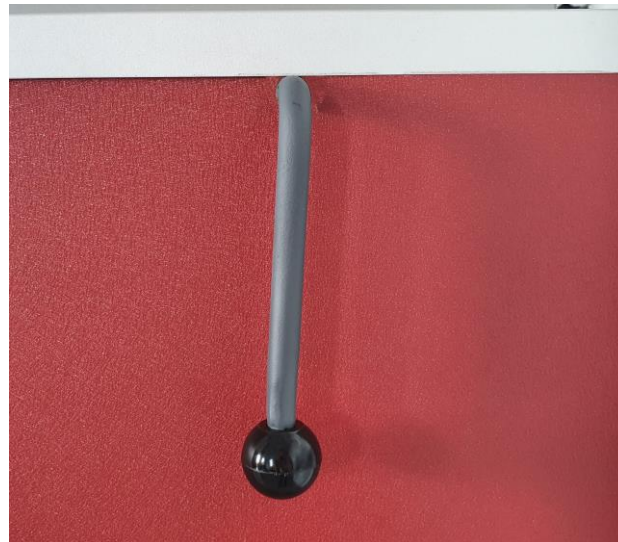
Abbildung 8: Kurzschlussklappenhebel in geschlossener Stellung.
