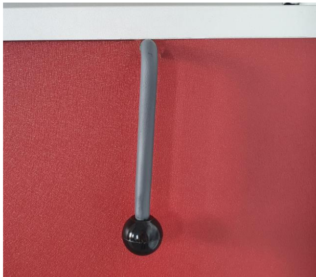
Abbildung 8: Kurzschlussklappenhebel in geschlossener Stellung.
