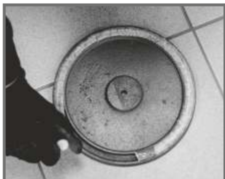
Fot. Wymiana sznura uszczelniającego.
